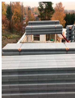
FKE Elementtien asennus
