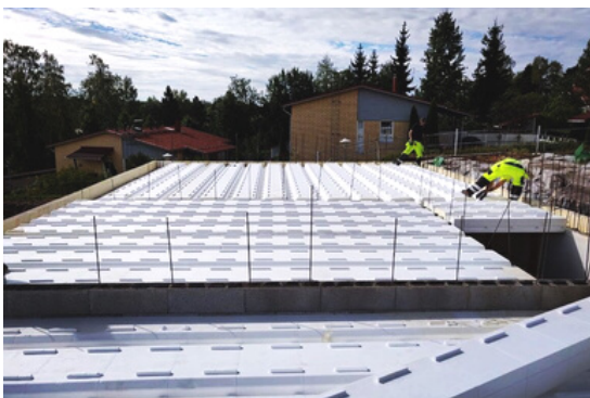
Kuva 4: FLE elementtien asentaminen
