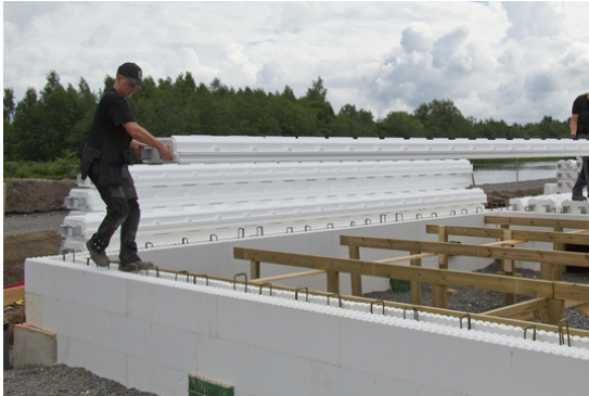
Kuva 1: FLE elementtien asentaminen
