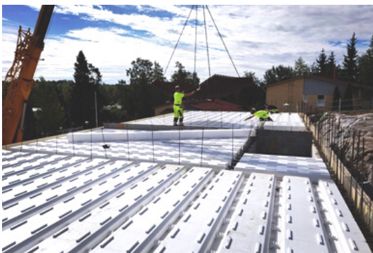
Kuva 3: FLE elementtien asentaminen
