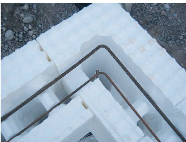
Kuva 7: Esimerkki kulmaratkaisun toteuttamisesta.
