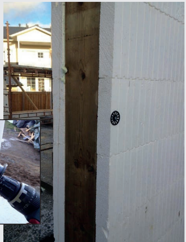
Kuva 18: Esimerkki kiinnitystavasta FinnEPS-avoharkolla toteutettuun aukkoon.
