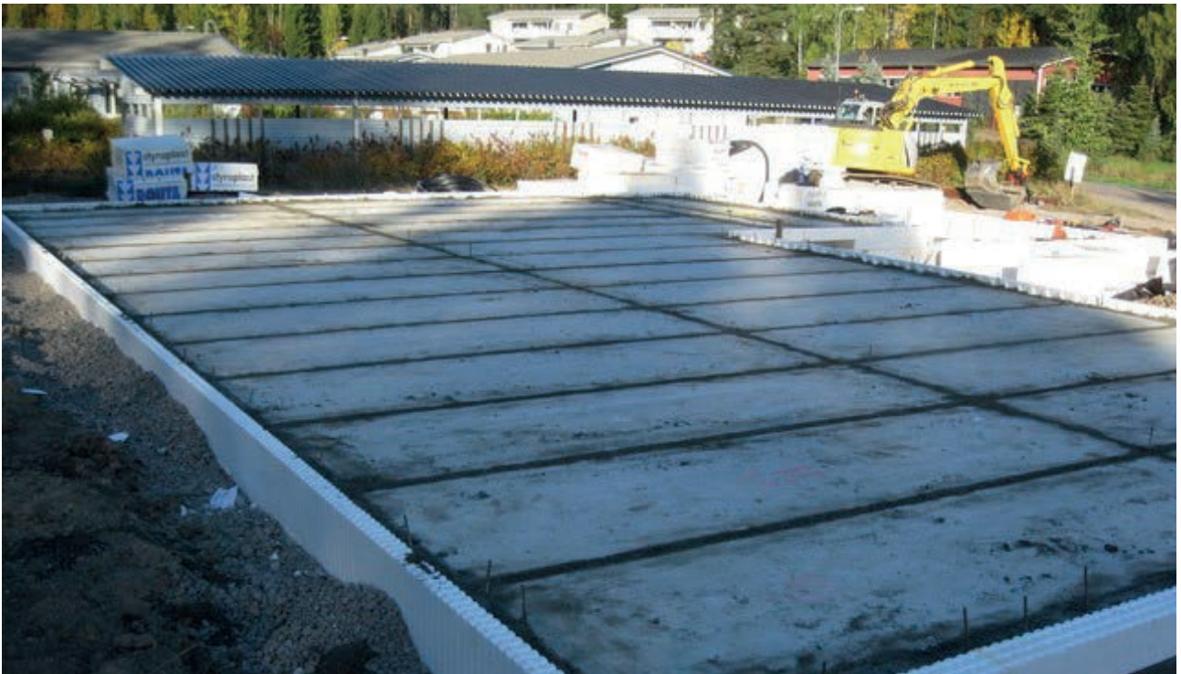
Kuva 16: Välipohja ontelolaatoilla toteutettuna.
