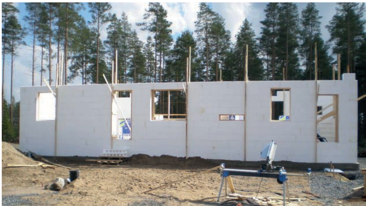
Kuva 14: Esimerkki suoran seinärakenteen pystytuennasta sekä aukkojen tuennasta.
