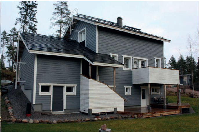
Kuva 24: Puuverhoiltu FinnEPS-harkkotalo.
