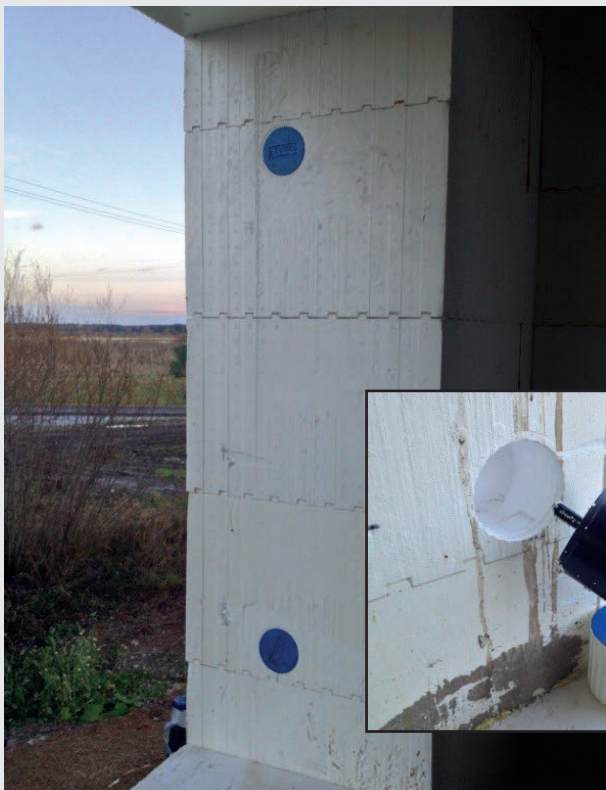
Kuva 17: Esimerkki kiinnitystavasta FinnEPS-päätyharkolla toteutettuun aukkoon.
