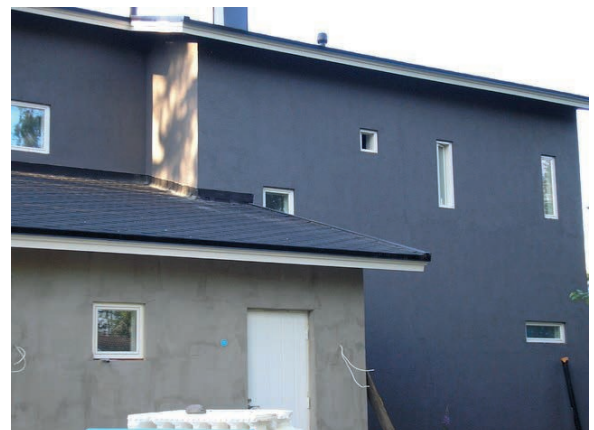
Kuva 21: Valmis rapattu FinnEPS-harkkoseinäpinta sekä pohjarapattu pinta.
