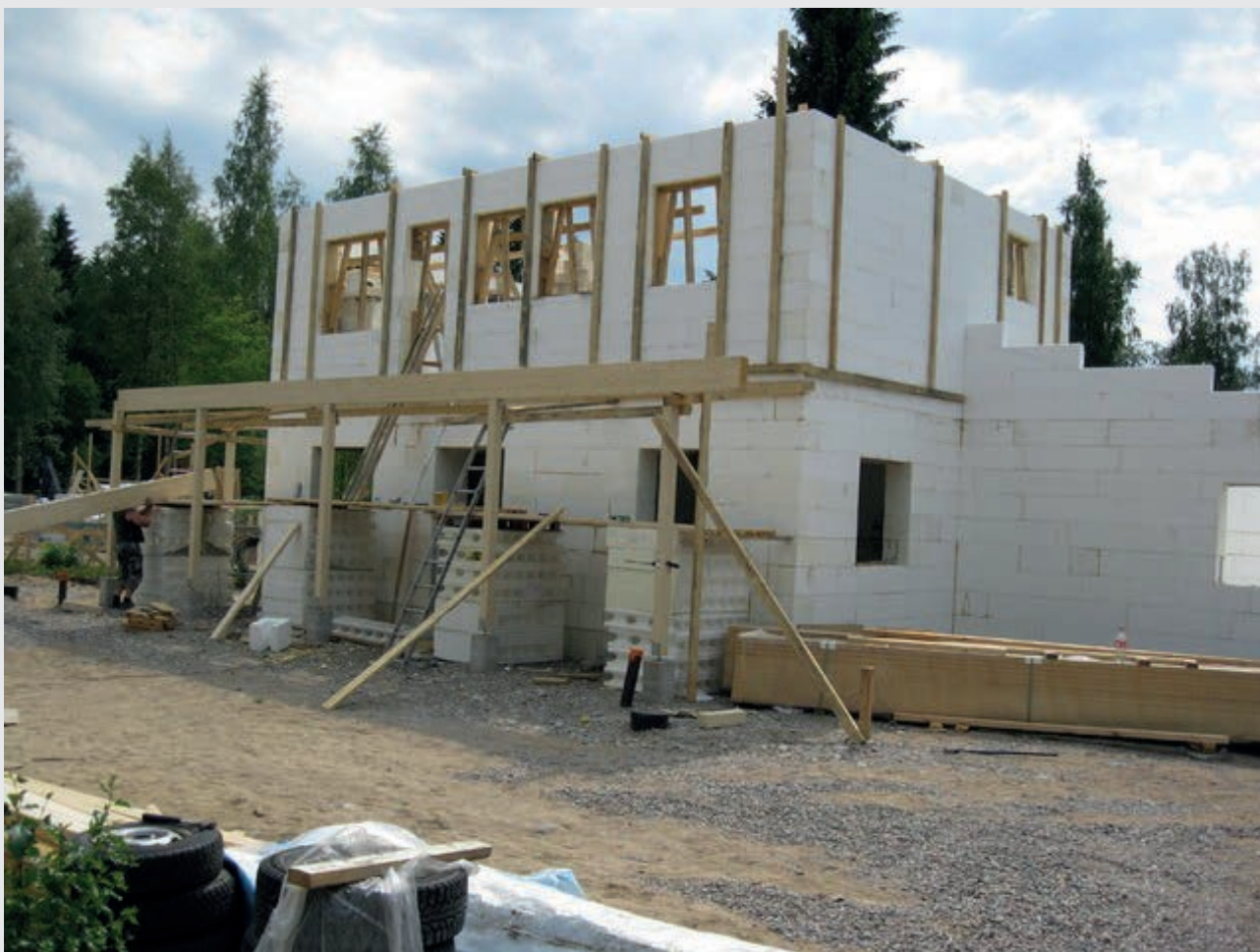
Kuva 15: Esimerkki toisen kerroksen seinärakenteen tuennasta.
