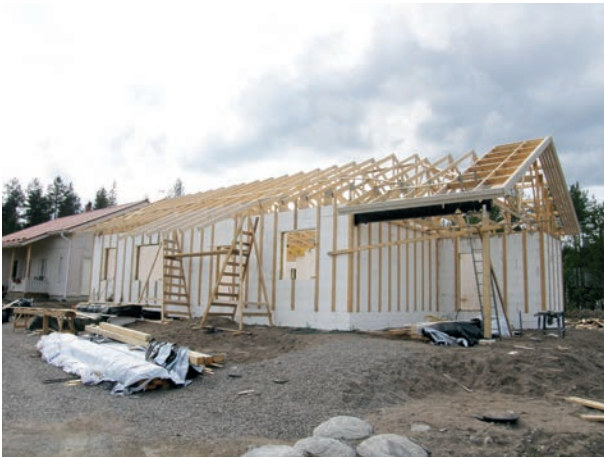
Kuva 23: Kiinnitysjuoksut puuverhoukselle.
