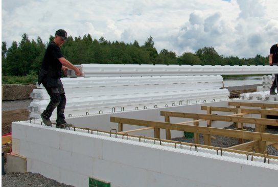
Kuva 1: FLE elementtien asentaminen
