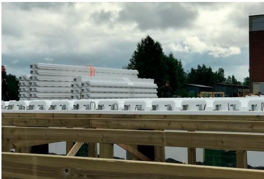
Kuva 2: FLE elementtien asentaminen
