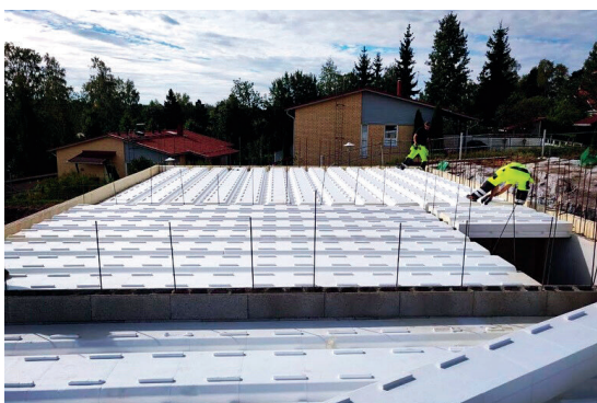
Kuva 4: FLE elementtien asentaminen
