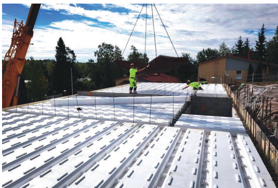
Kuva 3: FLE elementtien asentaminen
